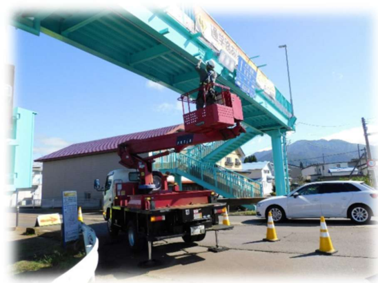
定期点検実施状況
