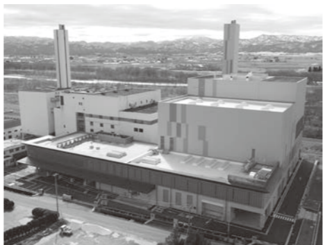
4月より稼働のごみ焼却施設
