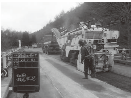
達沢大橋補修工事の路面切削の様子
