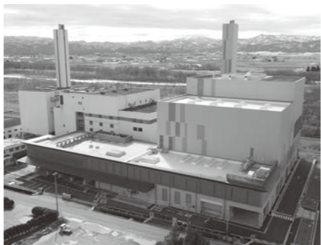
4月より稼働のごみ焼却施設
