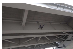
ドローンによる桁下の点検
