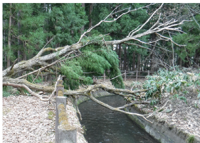
倒れた木が水路を覆う
